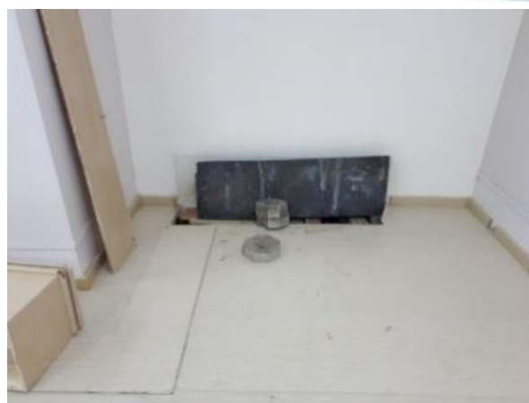
Зураг 3. Кабелийн оролт нэмэлт хамгаалалт хийхийн өмнөх (дээд) болон дараах (доод).
