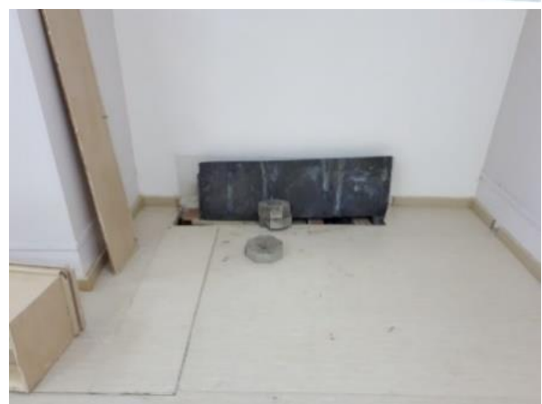
Зураг 3. Кабелийн оролт нэмэлт хамгаалалт хийхийн өмнөх (дээд) болон дараах (доод).
