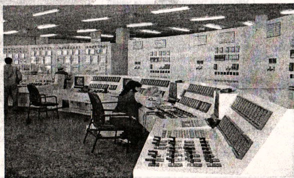
УБ хотын 4-р цахилгаан станцыг сэргээн засварлах төсөл Project for Rehabilitation of 4 th Thermal Power Station
