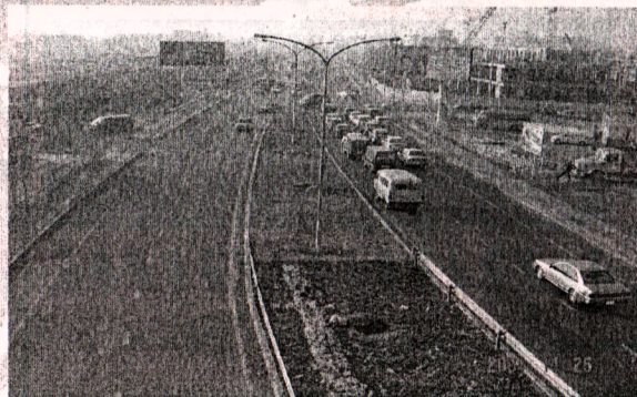
УБ хотын авто замыг сайжруулах төсөл Project for Improvement of Road in Ulaanbaatar
